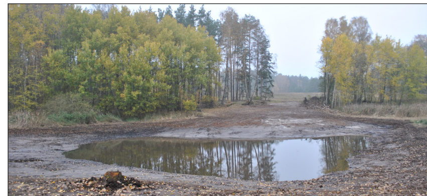
Der Igelpfuhl kurz nach Abschluss der Bauarbeiten.
