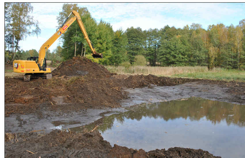
Bagger während der Bauarbeiten an der neu entstandenen Wasserfläche
