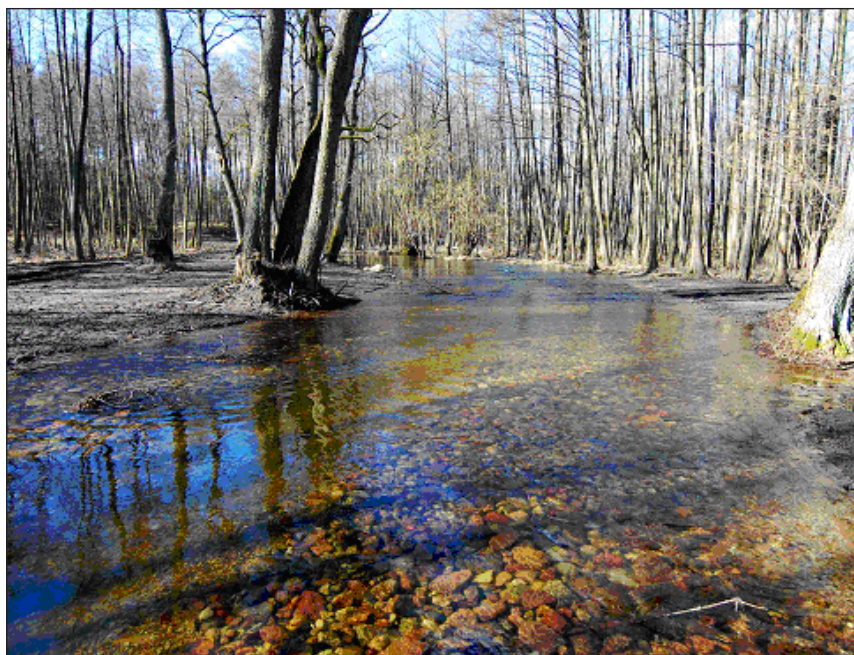
Sohlgleite an der Furt mit Niedrigwasser-Fahrerinne für Paddler, direkt nach dem Bau.
