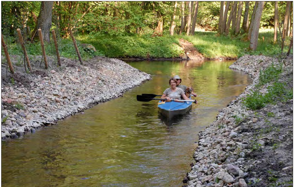
Das Umgehungsgerinne an der Floßschleuse IV wird von Kanutouristen dankbar angenommen.
