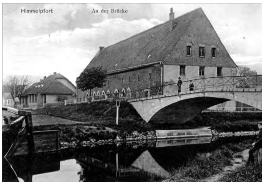
Historische Postkarte um 1920: Der Ostgiebel mit der Schleusenbrücke.
