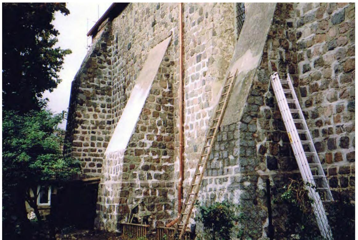
**Foto rechts, 1996 ...seine Leitern zum Ausbessern der Fugen in den mittleren Bereichen der Fassade. Die neuen Dachrinnen sind in beiden Fotos bereits zu erkennen.**
