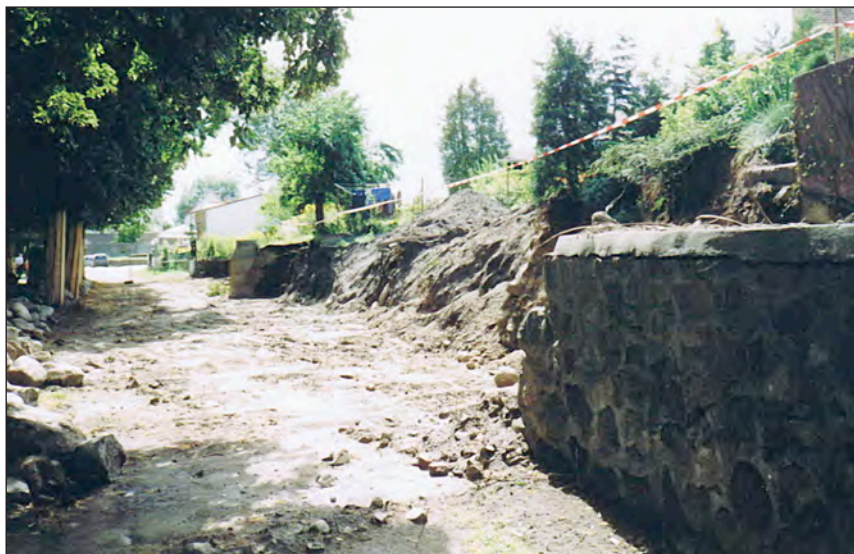
Sommer 2004 Strandpromenade: Sanierung der Stadtmauer
