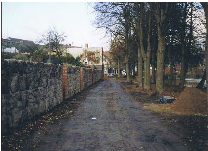
Herbst 2004: Die Sanierungsarbeiten sind abgeschlossen.
