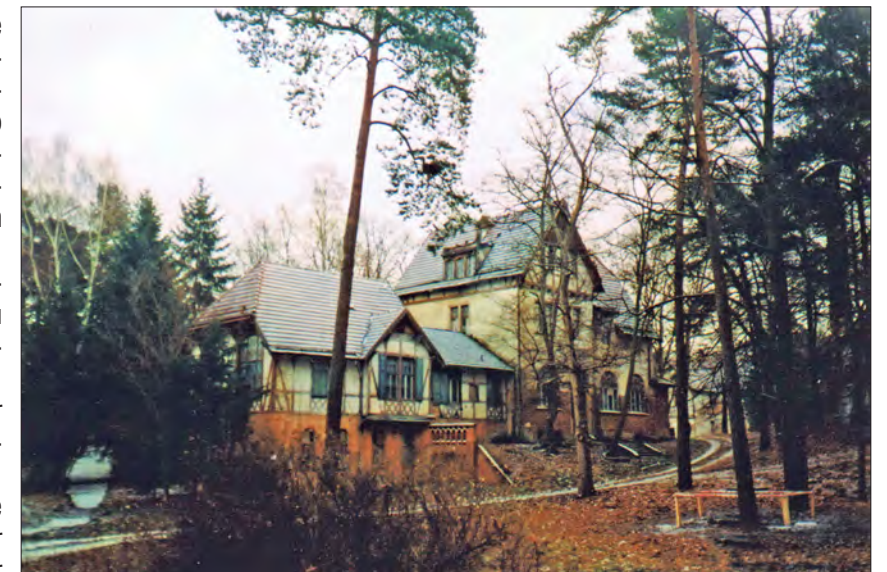
Foto: In diesem Haus sollen sanierte Ferienwohnungen entstehen.
