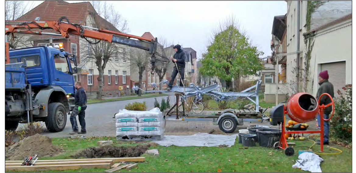
Vorarbeiten für die Errichtung der Skulptur.
