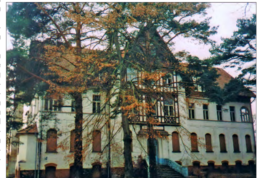
Foto: In diesem Haus sollen 6 Wohnungen entstehen.
