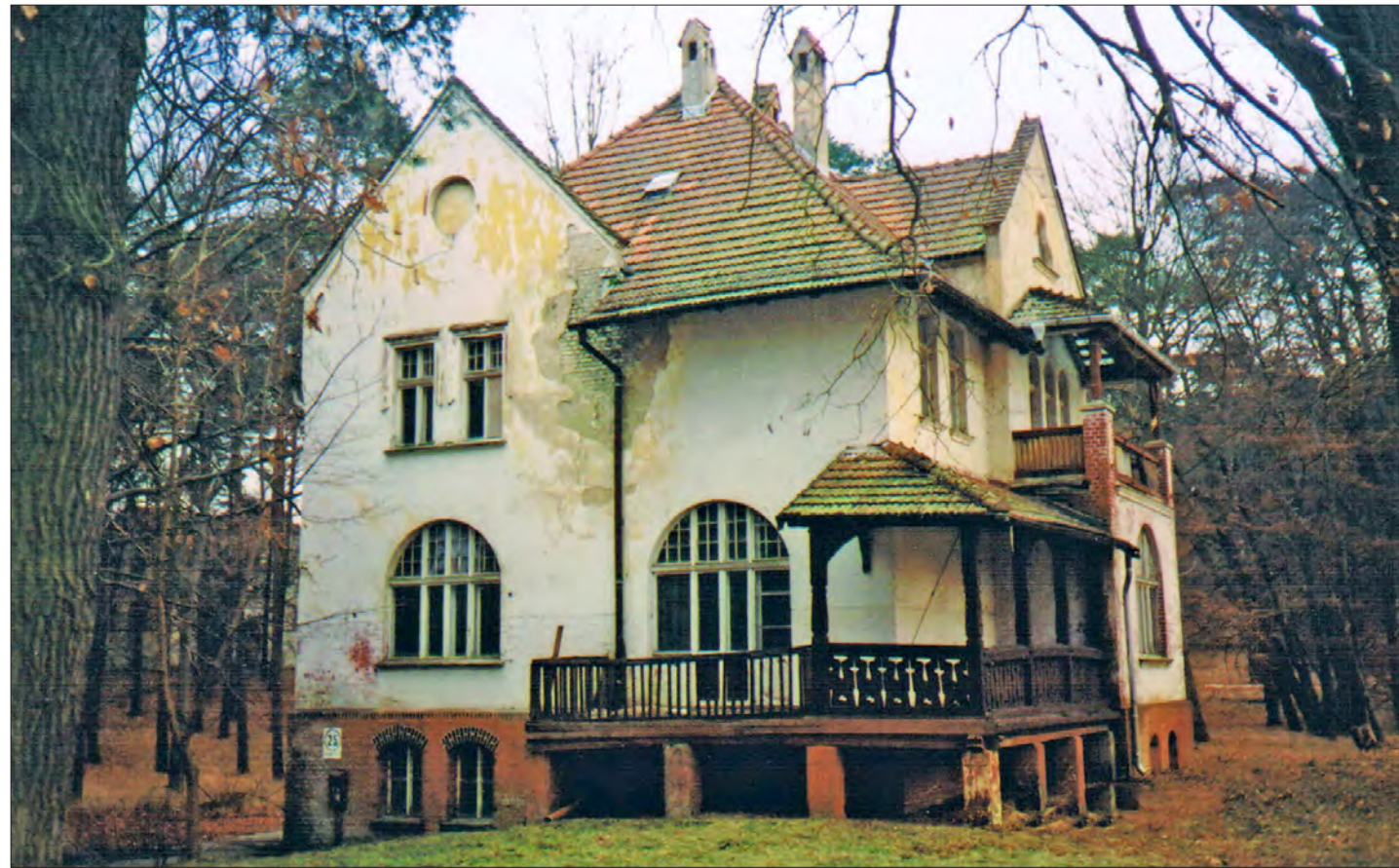
Foto 1: Heilstätten Hohenlychen, Villengebäude - Zustand 2001 , vor der Sanierung. Vergl. Templiner Zeitung vom 27./28.12.2015 , ...nach der Restaurierung.
