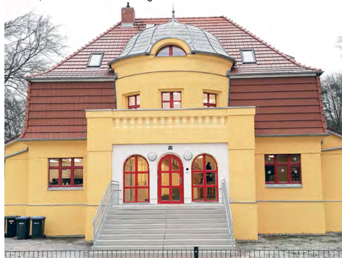
Saniertes Gebäude, Kindergarten
